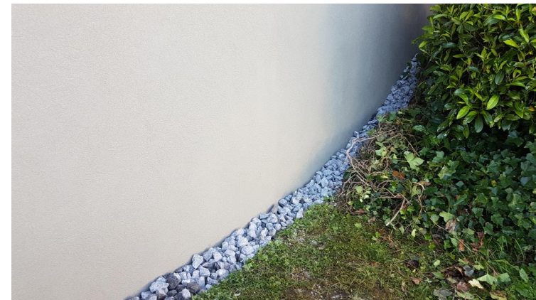
Bodenanschluss mit Steinen geschützt
