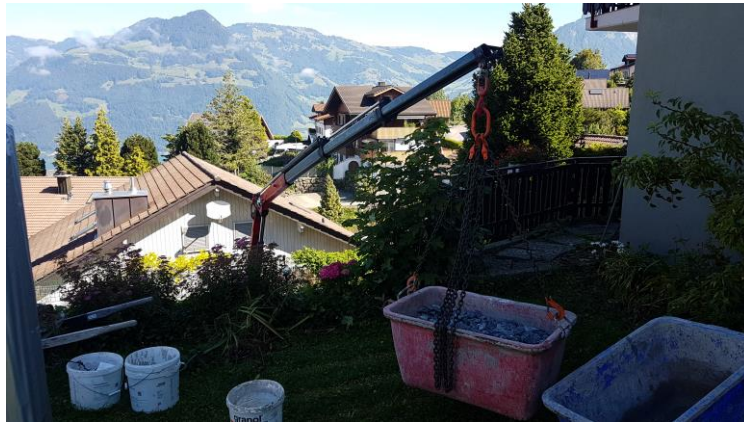
Steine mit unserem Firmenfahrzeug heben
