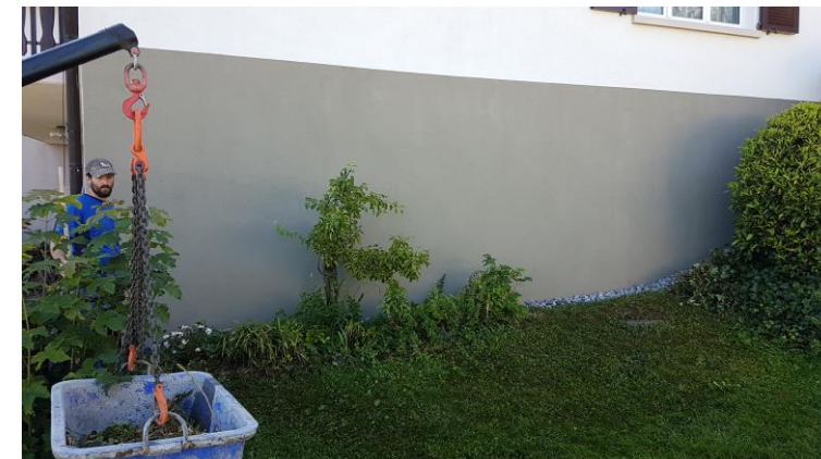
Abschluss der Arbeiten
