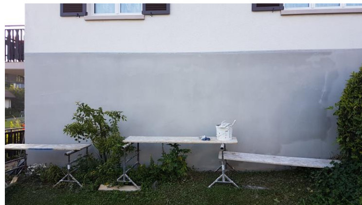
Vollflächiges Armierungsnetz einbetten
