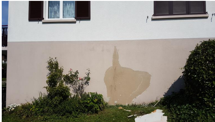
Entfernen des losen Verputzes
