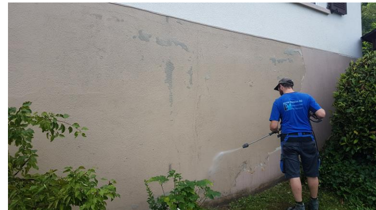
Abwaschen der Fassade
